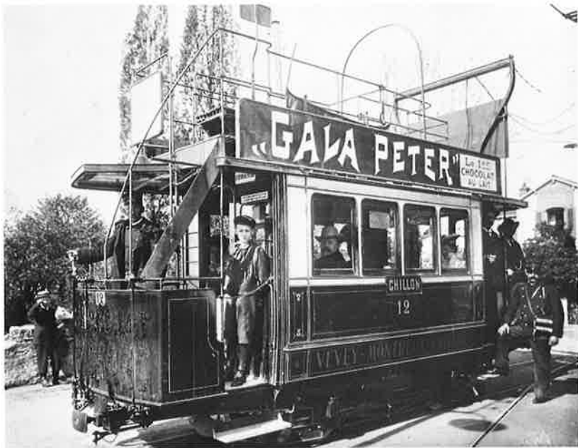
L'un des tout premiers trams devant le dépôt.
